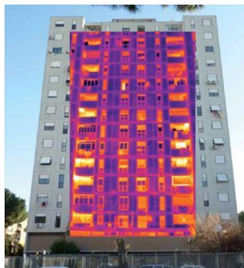
Immagine visibile/infrarosso Dispersioni energetiche – ponti termici
