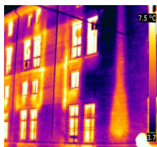
Dispersioni strutturali ed impiantistiche
